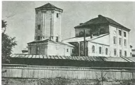
Церковь Троицы в Кузнецевской слободе. 1745 г.
